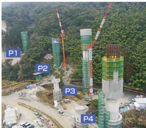
施工状況（P1～P4）
