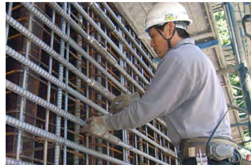
帯鉄筋組立て
