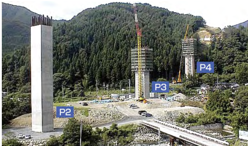
工事全景 (P2～P4)
