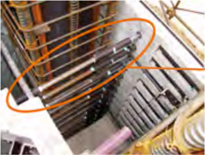
3 H パネル継ぎ手状況
