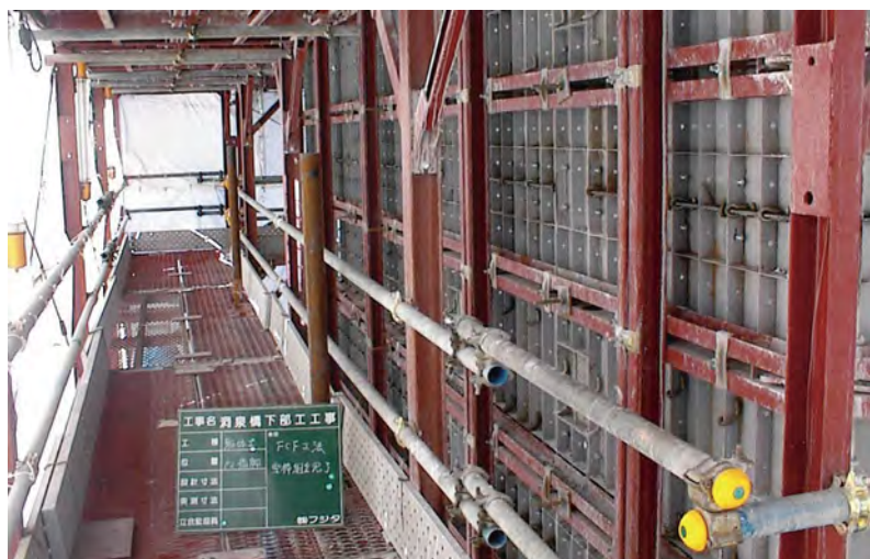
昇降式移動型枠 (外側)
