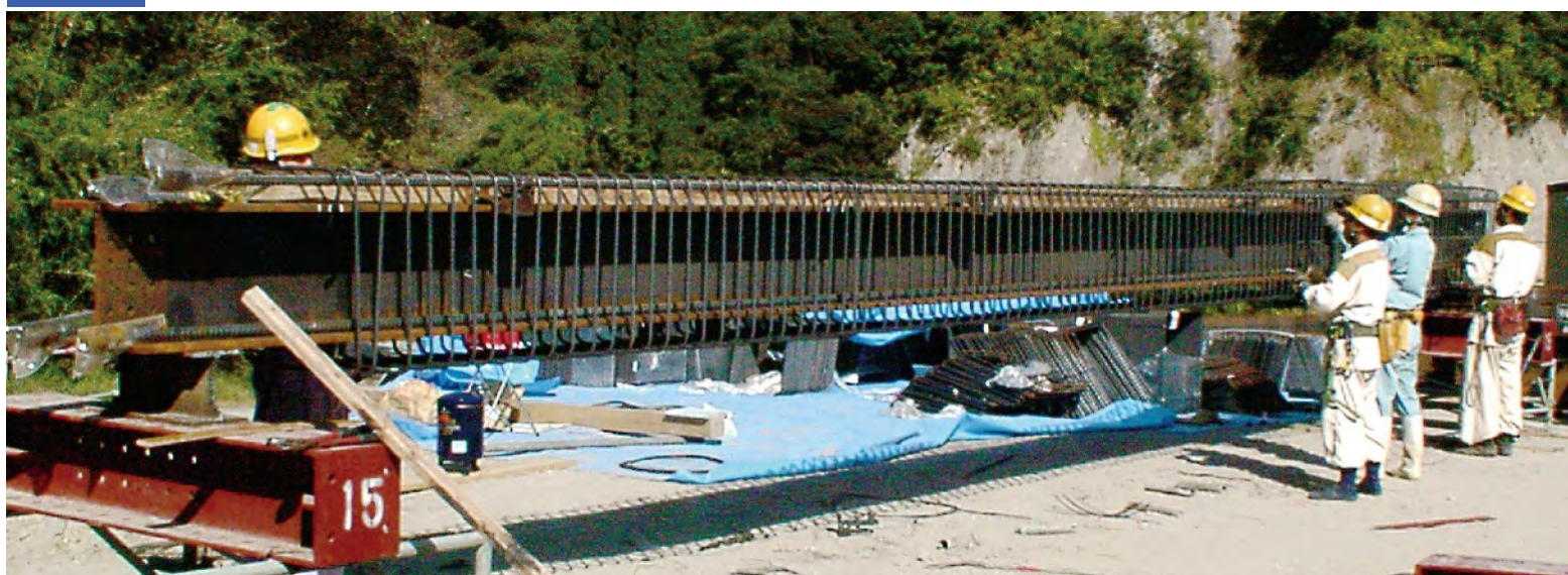
スパイラルカラム地組み
