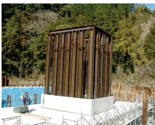
3 H パネル第一ロード設置完了
