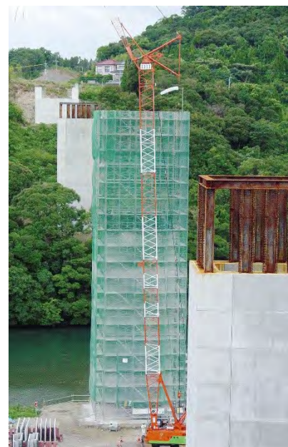
施工状況（P1～P3）
