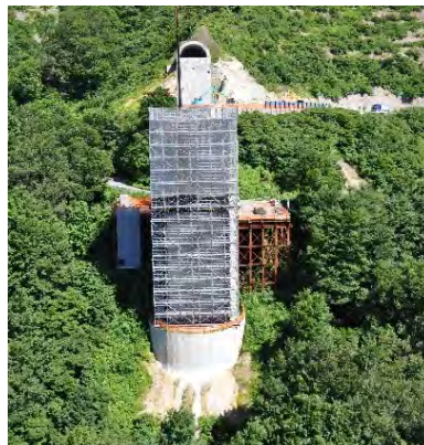
P 3 橋脚全景
