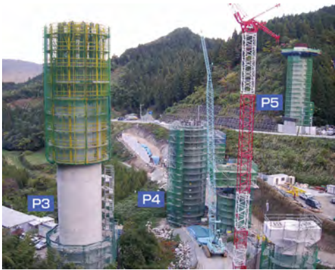
施工状況（P3～P5）
