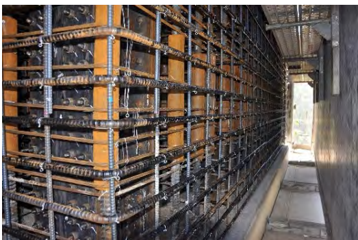
補強鉄筋及び帯鉄筋組立完了と昇降式移動型枠
