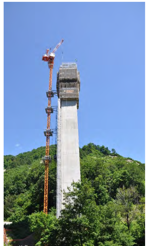
P 2 橋脚全景
