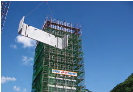
3 H パネル吊込み
