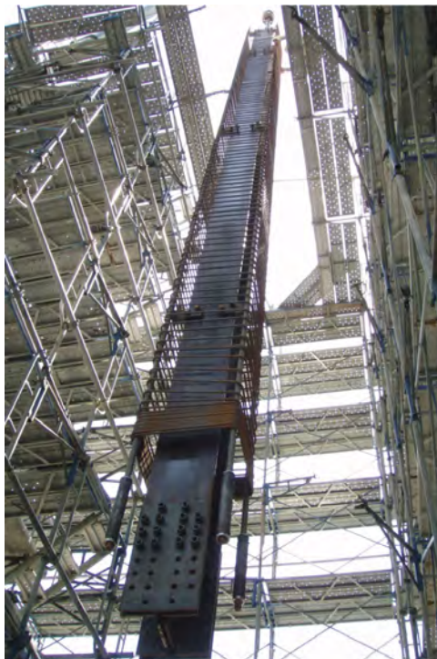
スパイラルカラム建込み
