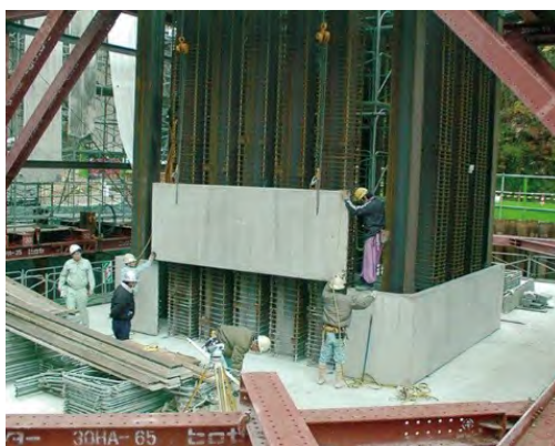
3 H パネル設置
