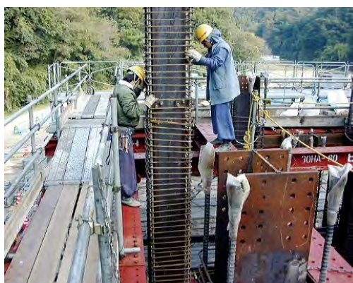
スパイラルカラム建込み
