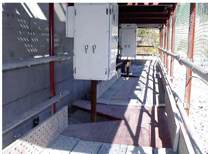
昇降式作業足場
