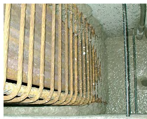
二次コンクリート打設
