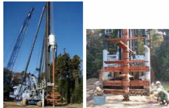
施工機械 (DH658)、掘削攪拌装置 (φ2600)
