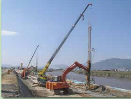
ロッド継足しによる施工
