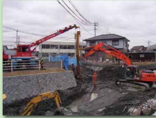
空頭制限下での施工
