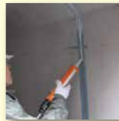
目地部への施工（内面から）
