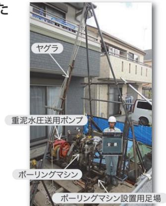
図5 従来技術で使用する調査設備の一例
