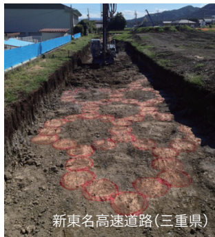
新東名高速道路（三重県） 建設工事振動（振動伝播経路）
