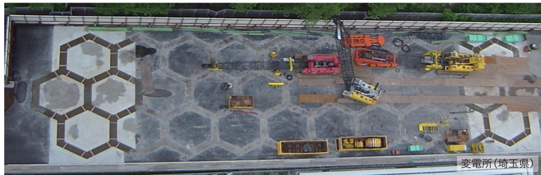
変電所（埼玉県） 工場振動（振動伝播経路）
