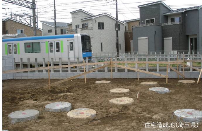
住宅造成地（埼玉県） 鉄道振動（受振側直下）
