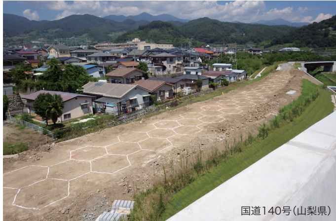
国道140号（山梨県） 道路交通振動（発振源直下）
