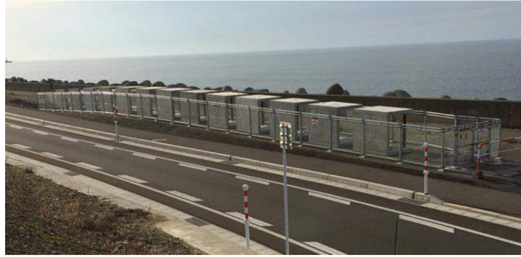
海岸沿いに設置された供試体 (新潟県糸魚川市押上地先、国道8号線海川大橋－東向オフランプ路脇)
