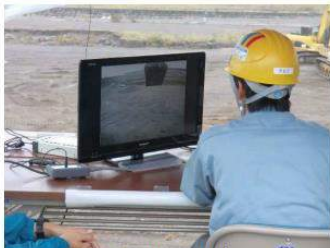
目視掘削実施状況
