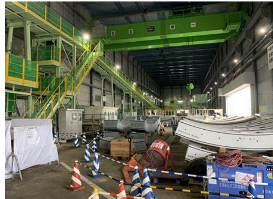
発進立坑(ベルコン設備、セグメント)
