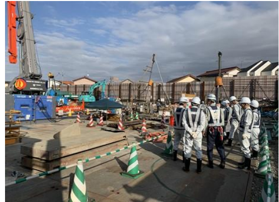
現場見学状況
