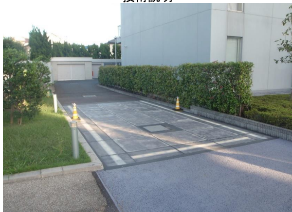
太陽光で発電する舗装システム(白線と街灯が発光している)
