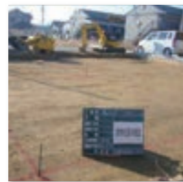
① 根切り掘削
