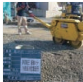
② 碎石撒き出し転圧
