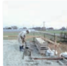
⑦ 端部押えコンクリート打設
