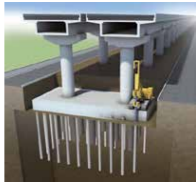
道路橋基礎の補強
