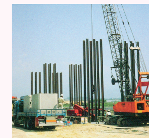
【鉄骨の建込み】
