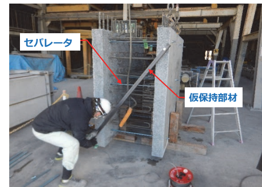
写真-2 ユニット化したプレキャスト側壁部材
