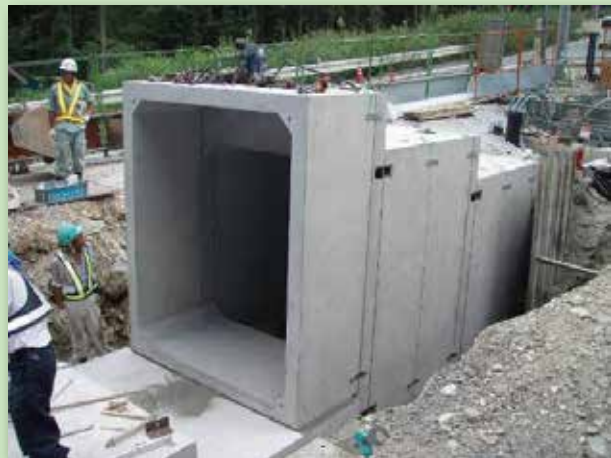
断面変化部への適用（落差部）
