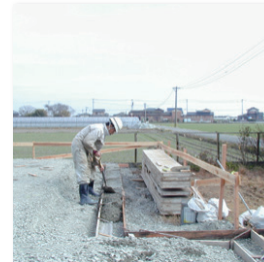
⑦ 端部押えコンクリート打設
