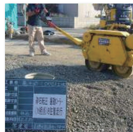
② 碎石撒き出し転圧
