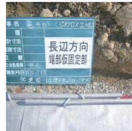
⑤ シート端部仮固定
