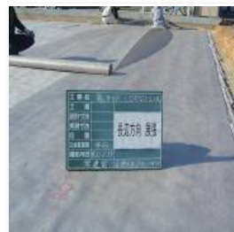
④ 長辺方向の敷設
