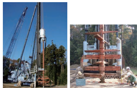
施工機械（100tクラス以上）、掘削攪拌装置（φ2600）
