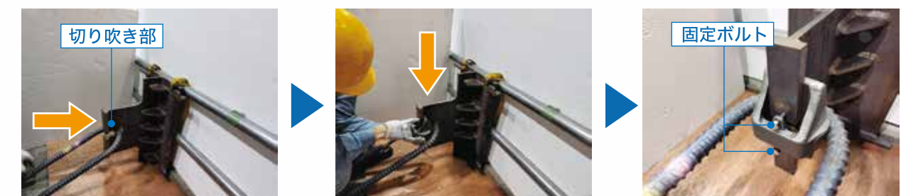
U字鉄筋を仮設置
