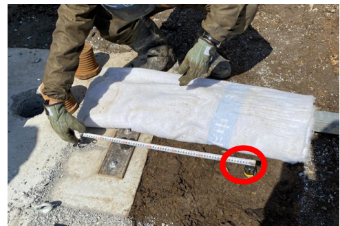
図-3 DTH 横の地盤に設置した加速度計
