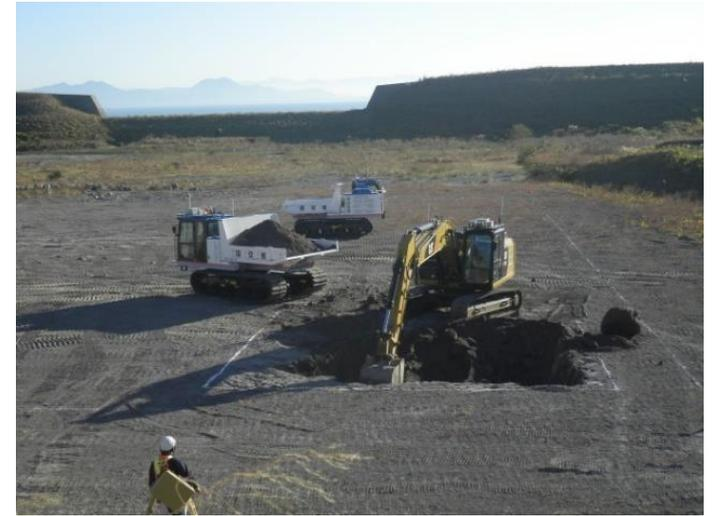
掘削・運搬試験状況
