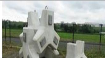
大成建設・T-eConcrete/Carbon Recycle
