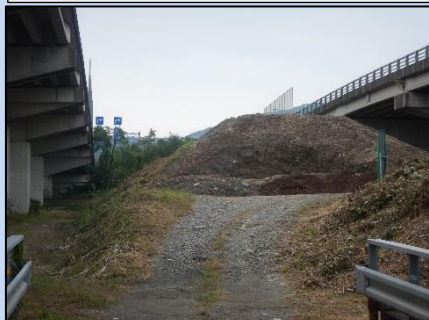
公共工事の建設発生土
