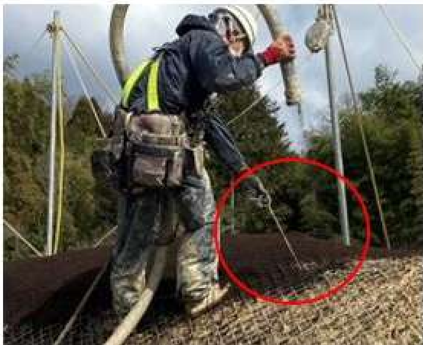
作業中の吹付厚確認状況
