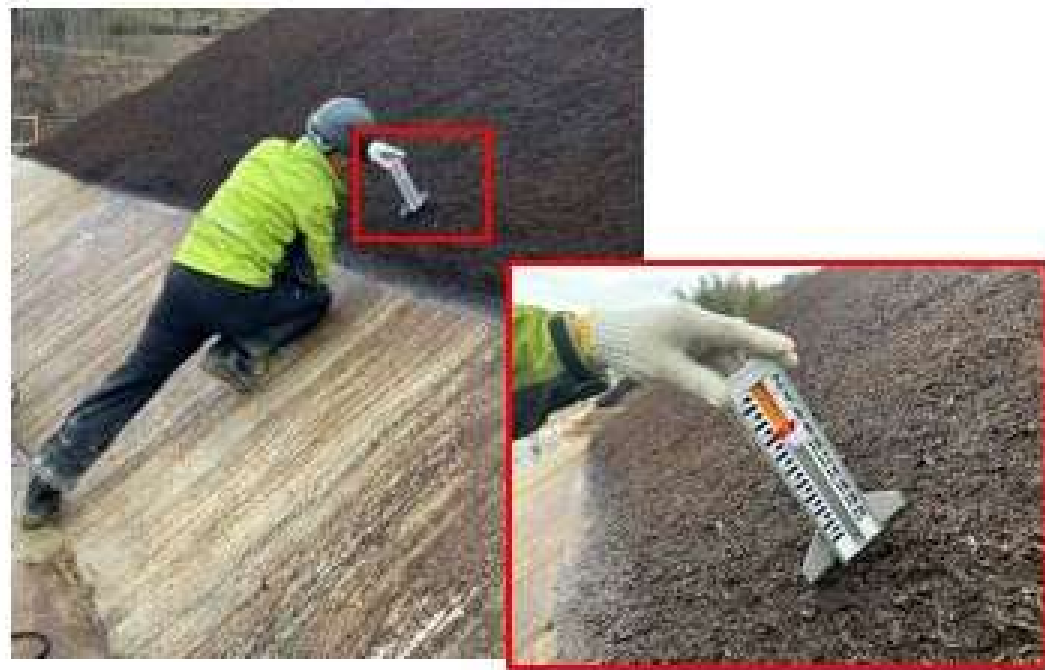
作業後の吹付厚（出来形）確認状況
